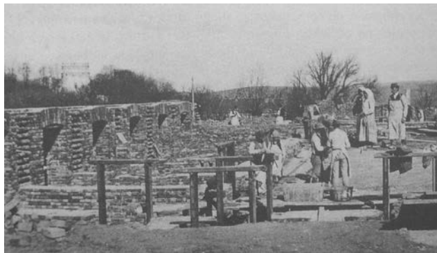
Prace budowlane przy nowym Klasztorze
